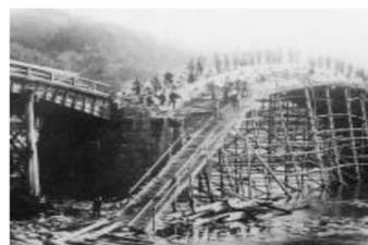
加えて再建しました。その後、昭和25年(1950年)キジア台風で流失しましたが、市民の熱意で岩国のシンボルとして昭和28年に再建されました。再建において創建時より改良された諸点として、橋脚基礎が深さ10mの鉄筋コンクリート井筒を使用している、中央橋脚において約80cm、両岸橋台において約50cmの嵩上げが行われた。桁受部は荷重を受ける隔石(へだていし)の代わりに沓鉄(くつてつ)を設け、橋体と橋脚の結合強化と雨水対策が講じられた。
